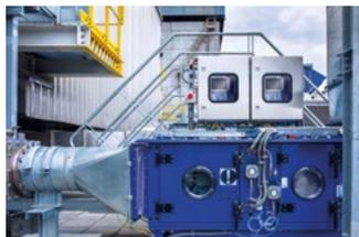
Regulación de la presión dinámica / psicrometría / temperatura / caudal de aire / TRA\*\* en las centrales de tratamiento del aire y los conductos
